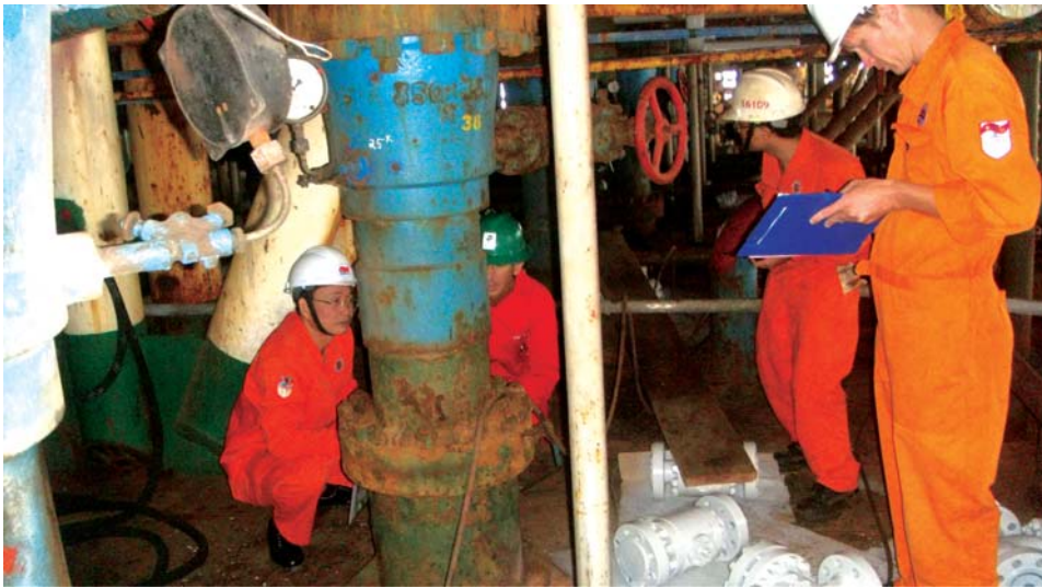
Hình 2. Khảo sát cây thông, đầu giếng kiểu OKK và AFK đã sử dụng gần 30 năm
