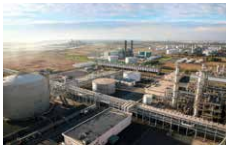
Nhà máy Đạm Phú Mỹ. Ảnh: PVFCCo
