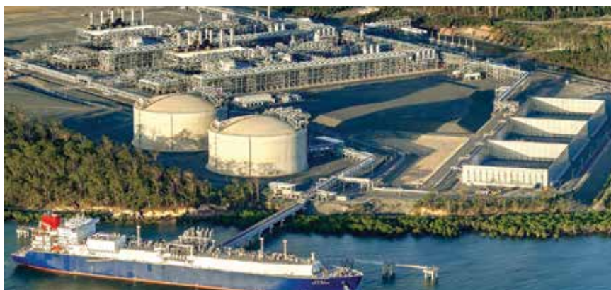
Nhà máy LNG của ConocoPhillips tại Australia. Nguồn: ConocoPhillips
