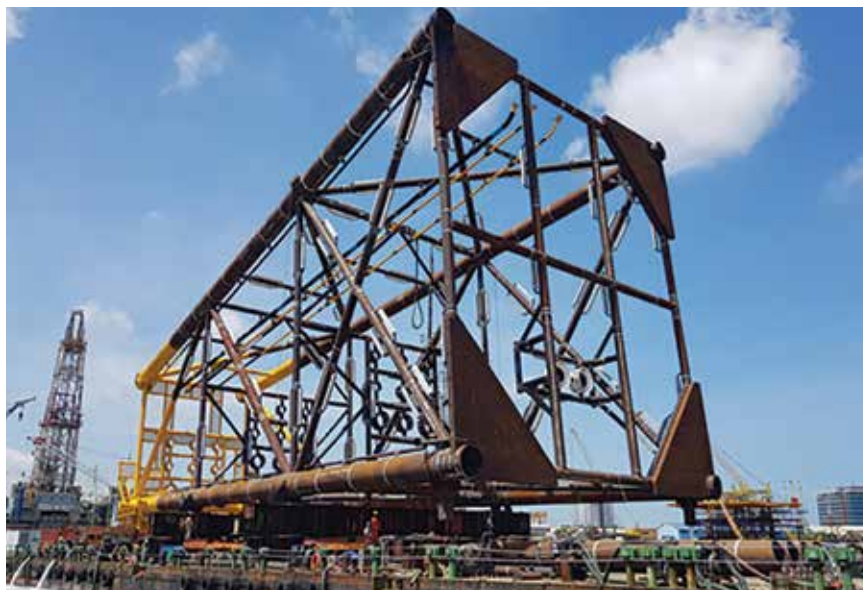
Chân đế BK-21 được hạ thủy xuống sà lan VSP-05. Ảnh: Vietsovpetro
