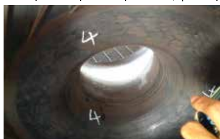
Bề mặt thân máy nén khí bị cọ xát phần lắp ghép với rotor 4
