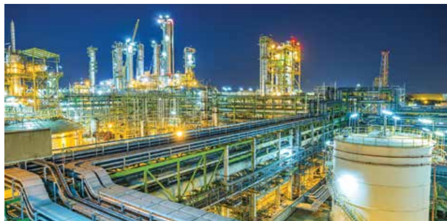
Cụm nhà máy chế biến dầu khí. Nguồn: Energy Dais
