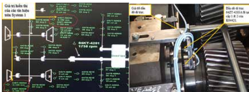
Hình 17. Lắp đặt đầu đo dịch chuyển của rotor và cấu hình tại hệ thống giám sát
