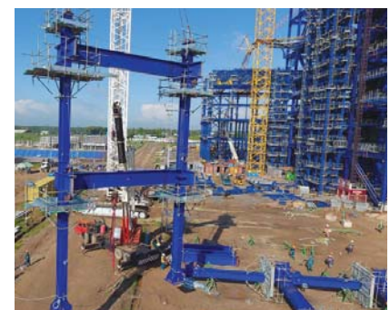
Lắp đặt kết cấu thép tại Tổ máy số 1. Ảnh: Lilama
