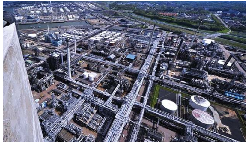
Nhà máy lọc dầu Pernis, Shell. Nguồn: OGJ
