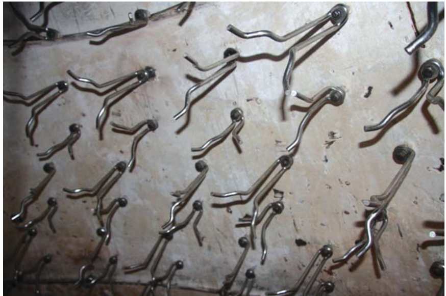
Hình ảnh Anchor theo thiết kế mới được lắp đặt vào thiết bị
